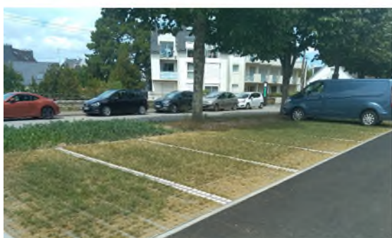
Fonction de stationnement + fonction hydraulique = parkings perméables
