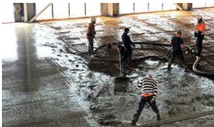
Coulage du béton en cours
