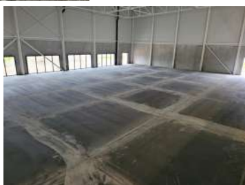
Béton fini surfacé
